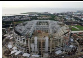
Gambar 2. Proyek Pembangunan Stadion Bertaraf Internasional
