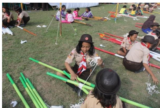
Gambar 4. Proses Pemasangan Struktur Gapura dengan Teknik Simpul dan Lashing
